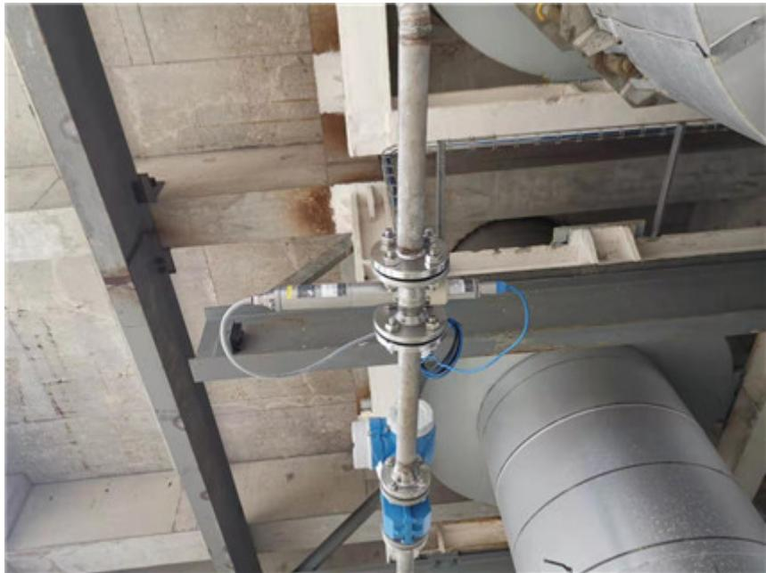
浊度分析---应用场合一束平行光垂直入射，穿透介质被介质内的颗粒散射，散射光与透射光被检测器检测到，散射光和透射光成11角，散射光强与透射光强的比值与介质内的颗粒含量成正比关系。典型应用：催化剂过滤回收工艺中的催化剂泄漏检测；结晶工艺中的结晶量检测；过滤工艺中助滤的添加检测；及时发现过滤器的故障（如：过滤膜破损）；过滤设备滤出产品检测；下游产品浓度检测；过滤器冲洗再生过程控制在线测量应用点实例：；盐酸羟胺项目中叔丁醇、氨水、甲乙酮肟中浊度0-100NTU；氯碱行业中一次盐水二次盐水浊度0-10ppm；己二酸脱色过滤器后浊度0-50ppm；分子筛设备损坏检测浊度0-100ppm；离心设备液相出口浊度0-100ppm；氨肟化装置膜过滤后清液浊度0-10ppm；MDITDIMDA生产中NaOH/NaCl浓度浊度0-2000ppm；催化剂回收过滤后浊度0-100ppm；橡胶、树脂在高温液态下成品浊度0-100ppm；聚合物在液态下成品浊度0-100ppm；双氧水浊度0-10ppm；驰光机电科技愿与各界朋友携手共进，共创未来！浙江尾气洗涤在线分析仪表生产商
